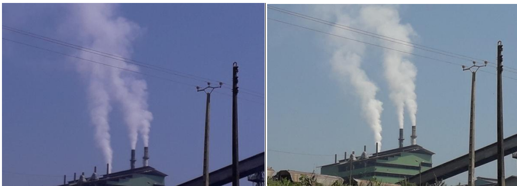
Etat de dégagement de poussières d'alumine par les trois (3) fours de Friguia pendant l'impact.
